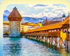
สะพานไม้ชาเปล
