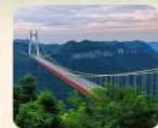
สะพานอ้ายจ้าย
