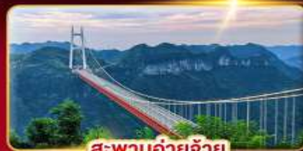
สะพานอ้ายจ้าย
