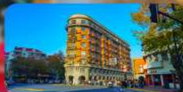
ถนนอันฝู & อาคารอู่คิง
