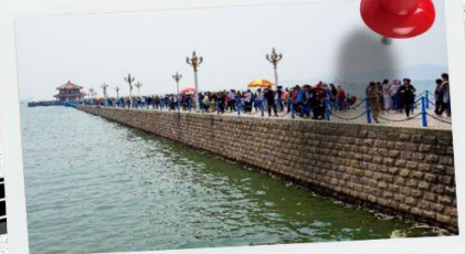
สะพานฉานเฉียว
