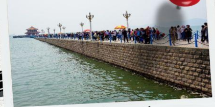
สะพานฉานเฉียว
