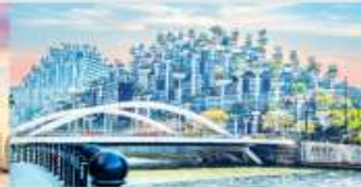
อาคารฟันทันไม้
