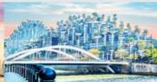
อาคารฟันทันไม้
