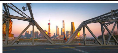
สะพานไวปี้ดู่
