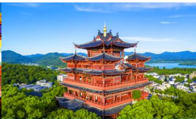
หอฉิวหวงเก้อ
