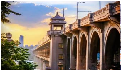
สะพานข้ามแม่น้ำหวู่ฮั่น
