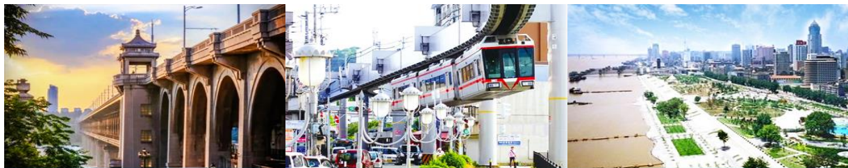
สะพานข้ามแม่น้ำหวู่ฮั่น
