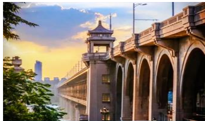
สะพานข้ามแม่น้ำหวู่ฮั่น
