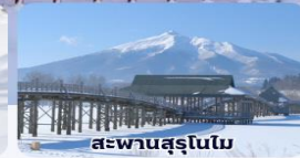
สะพานสุรุโนโม
