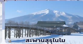
สะพานสุรุโนโม
