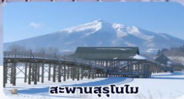
สะพานสุรุโนโม
